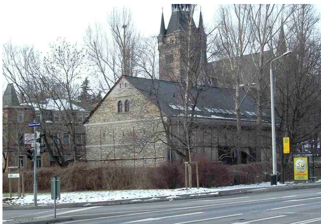
Ehemalige Scheune des Franz'schen Gutes
